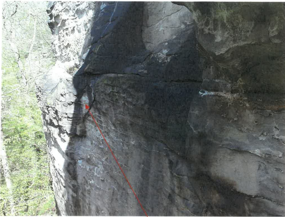
Bild 15: möglicher abkipppgefährdeter Felskörper
