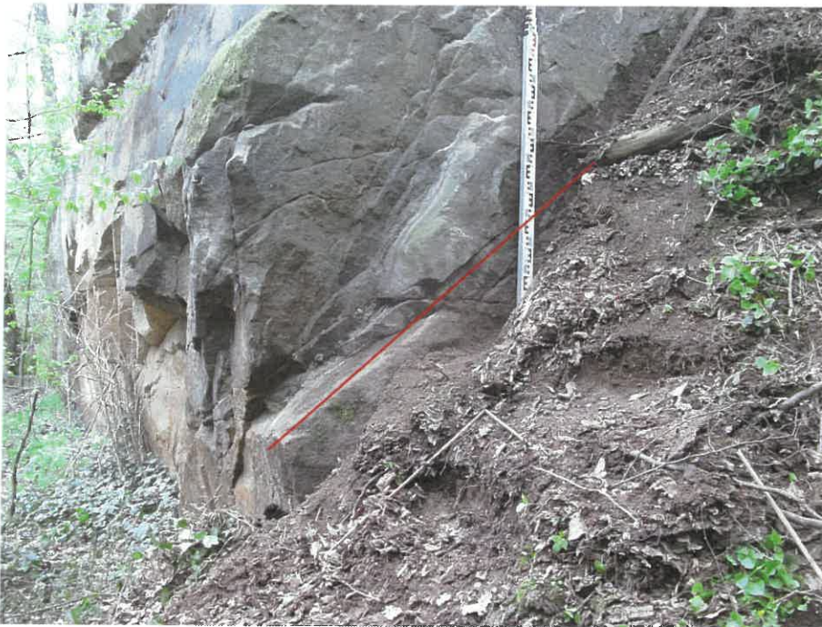
Bild 13: Schurf 4 talseitig einfallender Trennfläche
