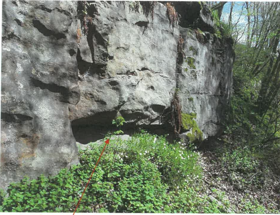
Bild 20: talseitig geneigte Trennfläche am Fuß des östlichen Felskörpers
