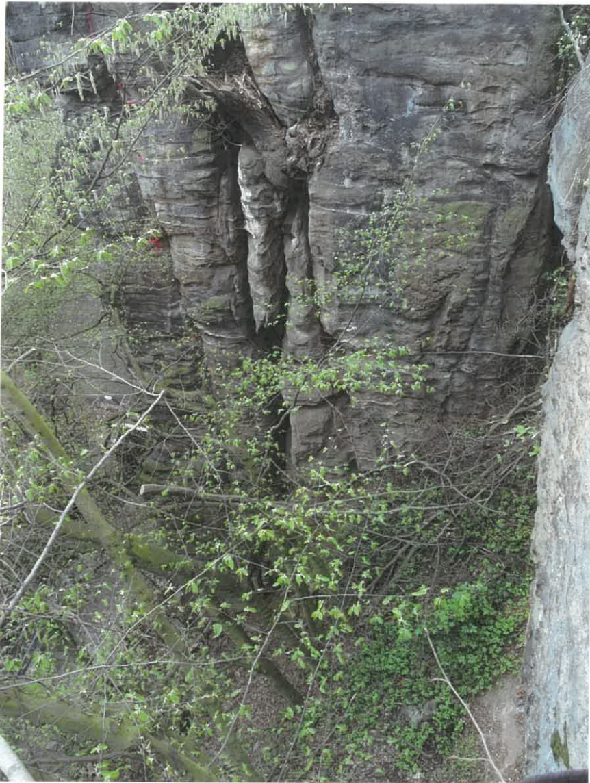
Bild 8: Ansicht der Ostseite mit ausgeprägten Vertikalklüften
