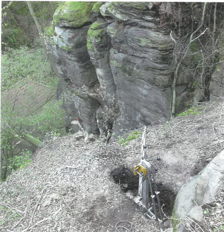
Bild 3: Bohrpunkt für die Kernbohrung 3
