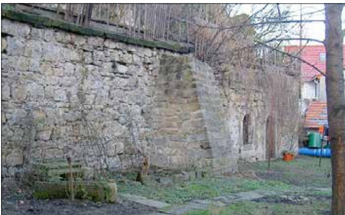
Ein Teil der südlichen Kirchmauer im Garten des ehem. Pfarrhauses (oben das Hauptportal, unten Eingang Zur Sakristei)
